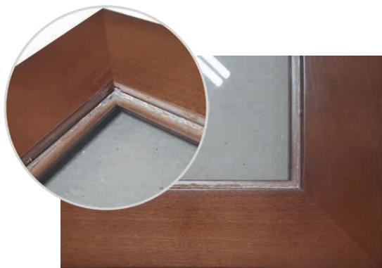
Простая вклейка (На фото тыльная сторона фасада)
